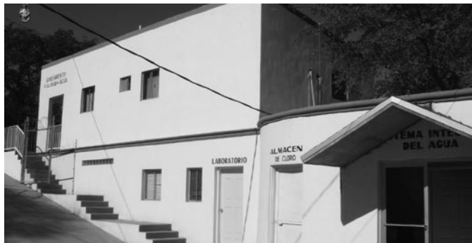
Oficinas Centrales y Laboratorio del Programa de Pre-tratamiento en Nogales, Sonora
