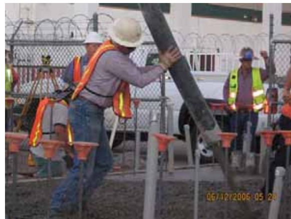
SB No. 3 Monolithic Slab/Stem Wall Pour
